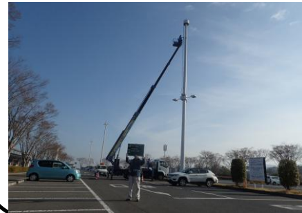
高所作業車による照明点検
